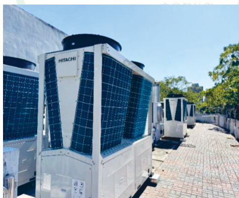
更換新型節能觀餐大樓冰水主機
