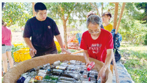
利用自然素材與回收玻璃瓶建造環保土窯
