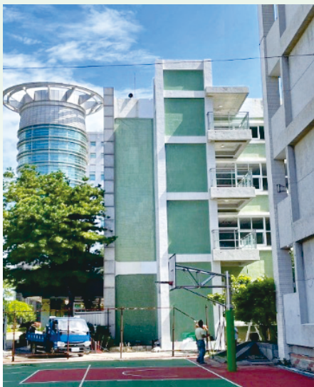
積中堂無障礙電梯
